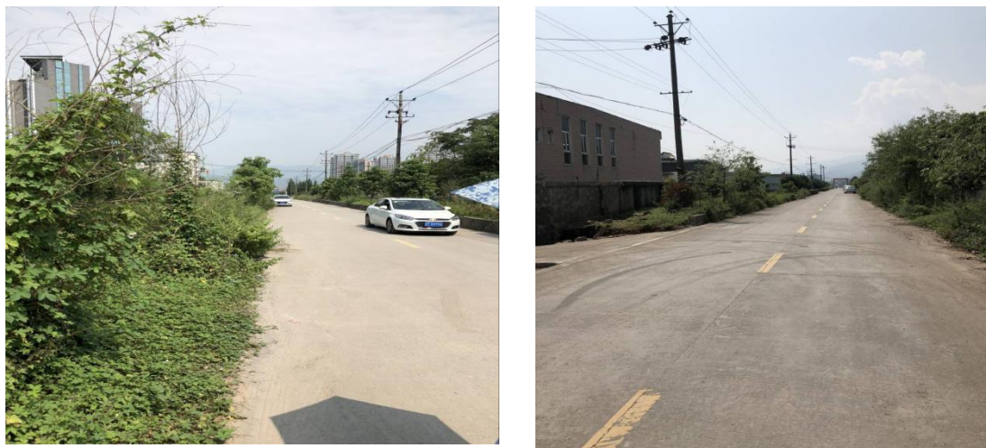
照片 2.1.4-1、兴贸一路北段道路现状
